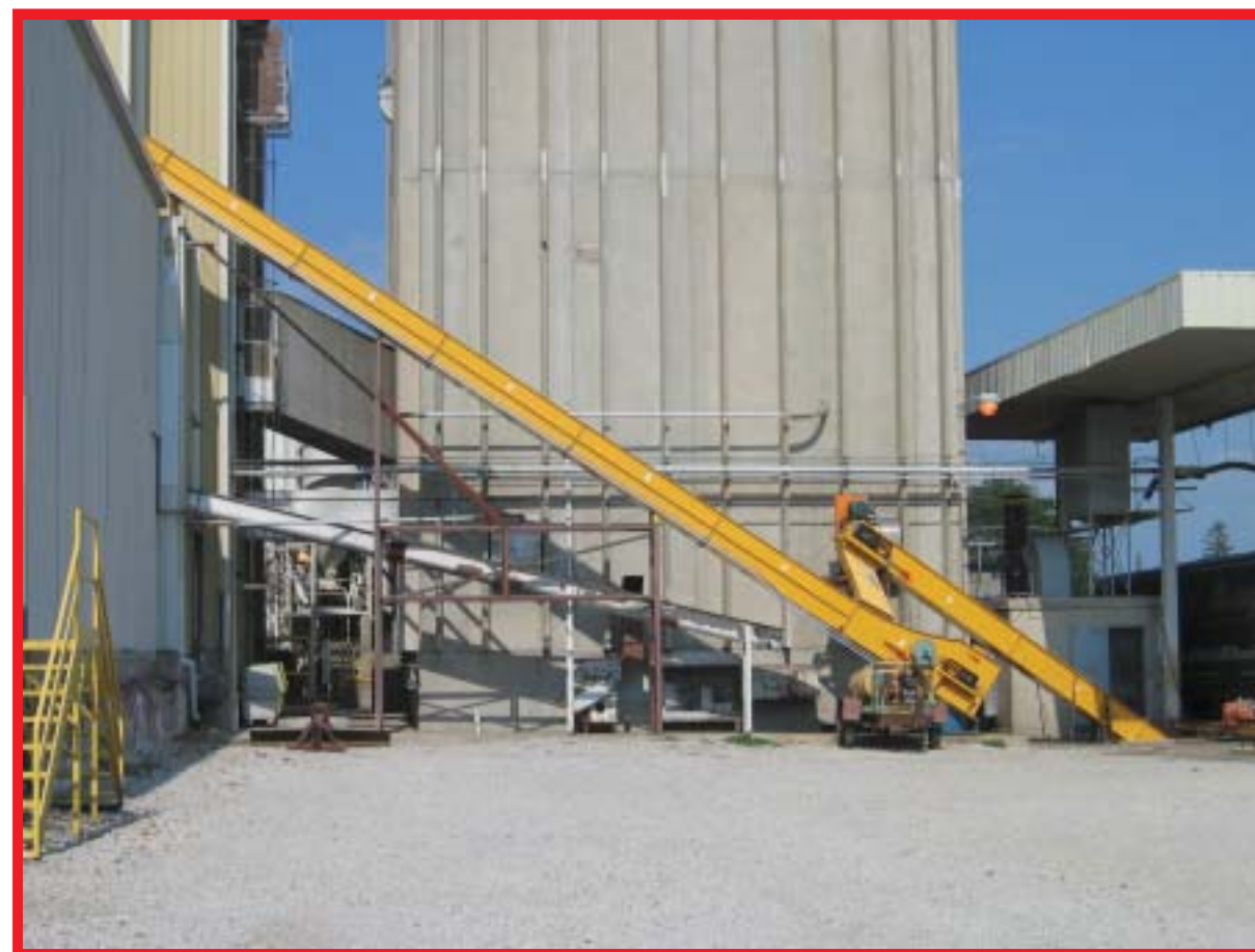
Rail Car Unloading System, Siemer Milling Co., Teutopolis, IL
